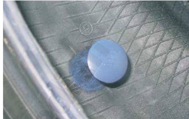
Bild 13: Einziehen eines Kombi-Reparaturkörpers. Bild: Blenk
